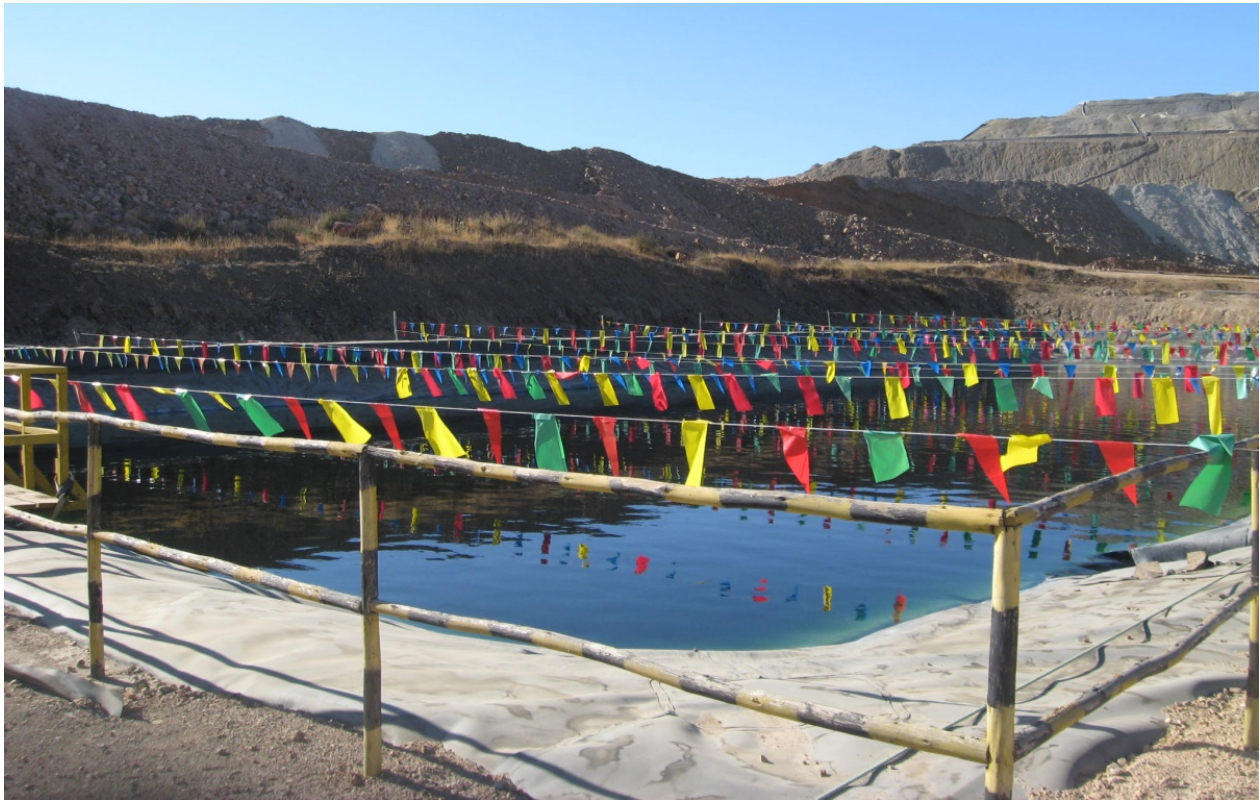
Figura 2: Sistema de línea de banderines sobre una de las piscinas de emergencia de la operación minera de Teck-CDA. / Flag line system on one of the emergency pools of the Teck-CDA mining operation.
